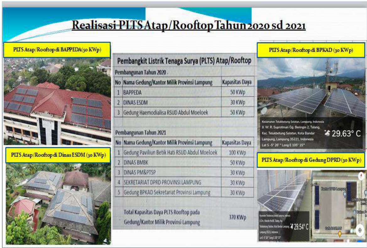
Gambar II-21 Realisasi PLTS Rooftop Tahun 2020 - 2021
